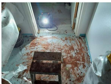
Figur 6 Spill under putsningen av badrum 2214 och rengjort resultat.
