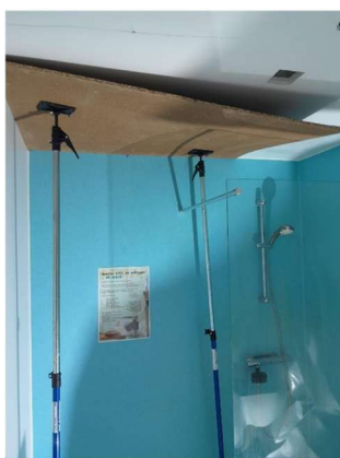
Figur 7 Montage av lerskivor i tak och kapade lerskivor på vägg.
