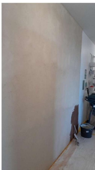
Figur 5 Väg i lägenhet 3101 med lerskivor och lerputs.
