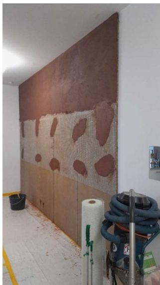
Figur 5 Väg i lägenhet 3101 med lerskivor och lerputs.
