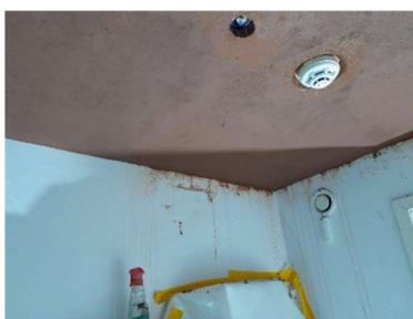
Figur 6 Spill under putsningen av badrum 2214 och rengjort resultat.
