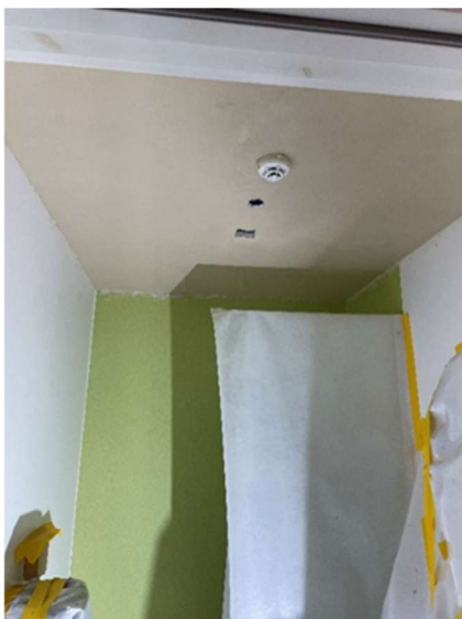
Figur 3 Badrum 2114 med lerputs i taket.
