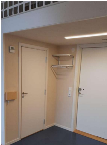
Figur 2 Klusterlägenhet 4108. Väggarna och taket i entrén är putsade med finkornig, vit lerputs.
